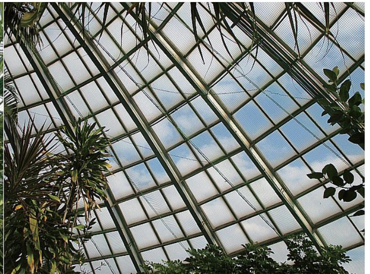
姫路市植物園の温室施設、台風や強風による園内施設のガラス仕様施設で観覧者の安全確保のご要望からセーフティネットをフォローする提案型落下防止ネットプランの施工例となります。天井向けの困難な施工にも対応いたします。
