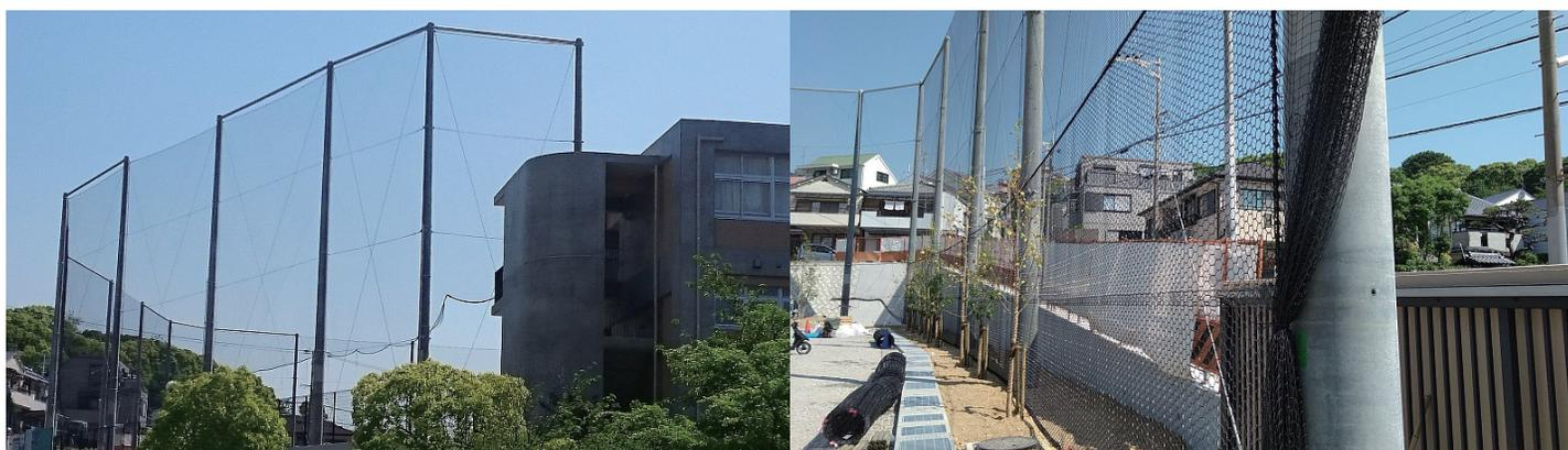
神戸市立の新設校の防球ネットの設計施工例と多目的メイングラウンドのハイポール仕様H14.9mの規格仕様とネットはブラックネット・下部はドレスネット施行例です。
